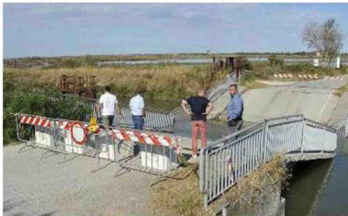
Il vecchio ponte crollato prima della demolizione
