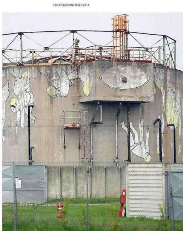
L'acquedotto del Cadf in via Marina a Comacchio
