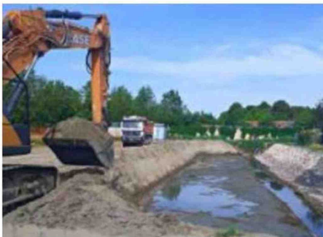
Per quanto riguarda l'intervento di Lido Nazioni, la spesa è di 2,7 milioni di euro e le opere riguardano la realizzazione di una vasca di prima pioggia in cemento, interrata
