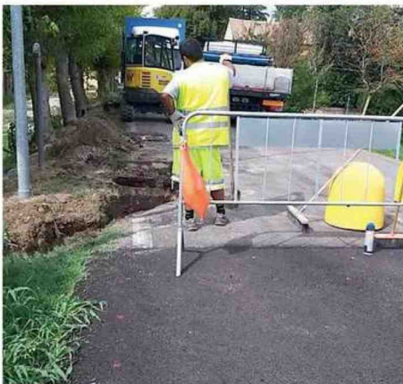
Via ai lavori Ieri mattina i primi interventi anche dopo la segnalazione del nostro quotidiano sui problemi del ponte fra Sabbioncello e Denore
