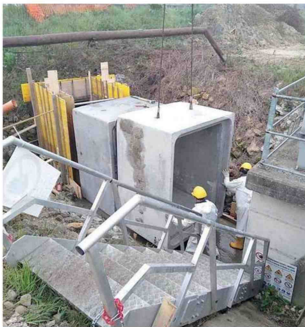
Il Consorzio di Bonifica Pianura di Ferrara sta andando avanti con una serie di lavori. In foto quello alla Tampellina
