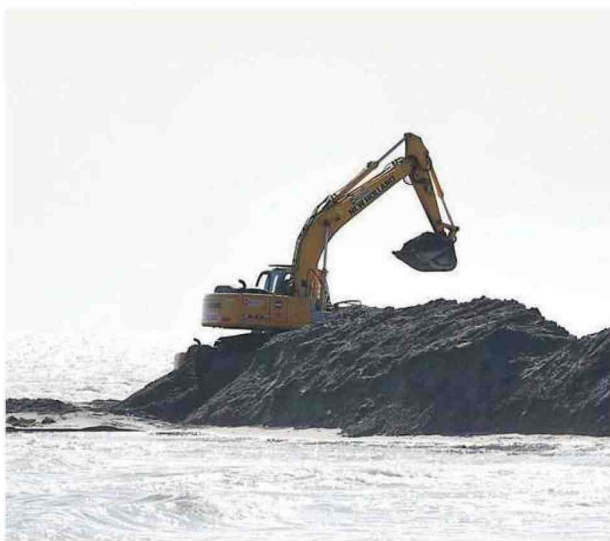
Danni ingenti causate dalle mareggiate anche a Lido Spina E la Regione Emilia Romagna interviene aprendo due grossi cantieri
