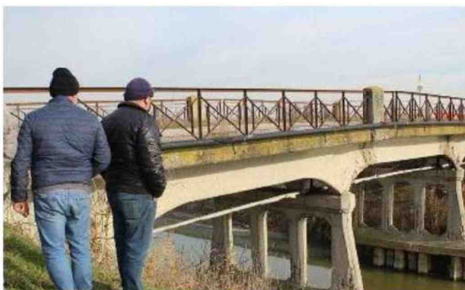
Il ponte della Barchessa che dovrà essere demolito e ricostruito
