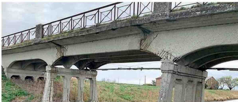
Il ponte della Barchessa sarà ricostruito
