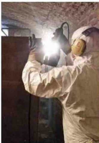
Lavori alle vasche di accumulo dell'acqua potabile (foto di repertorio)
