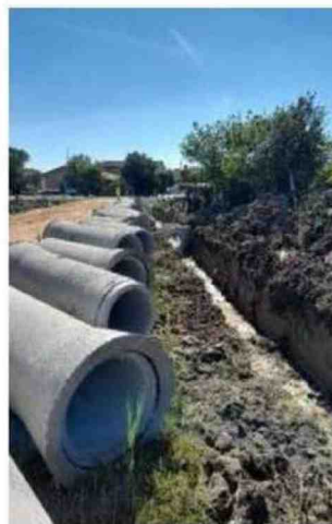
Una delle zone dove sono stati eseguiti i lavori di adeguamento
