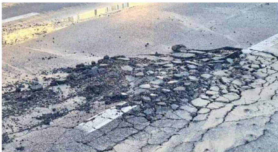
Il punto in cui si è rotta la condotta idrica e (sotto) i vigili del fuoco già al lavoro ieri a Rovereto
