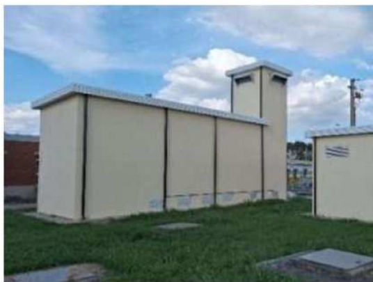
Nel territorio comunale, ma collegati alla centrale di potabilizzazione di Ro, si collocano anche i dieci pozzi nell'area golenale del fiume Po
