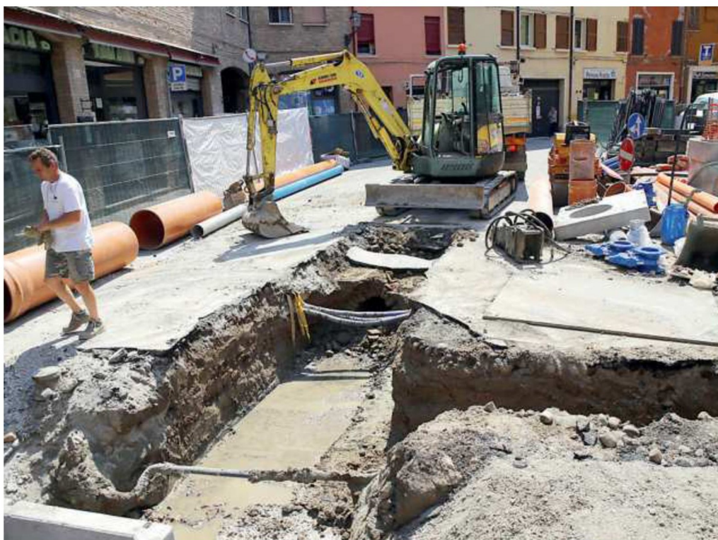
Lavori di rifacimenti a una rete fognaria. Gli investimenti del Piano operativo sono così suddivisi: 79,6 milioni saranno gestiti da Hera e 35 milioni saranno gestiti da Cadef (foto archivio )
