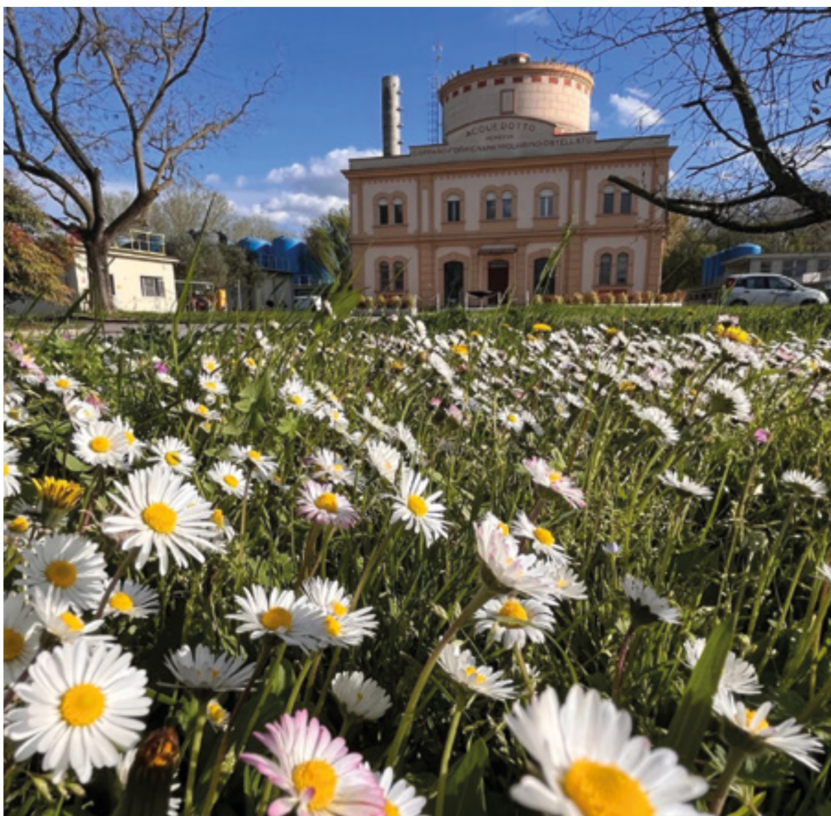
Centrale di potabilizzazione di Ro.
